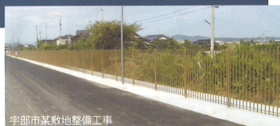
宇部市某敷地整備工事
