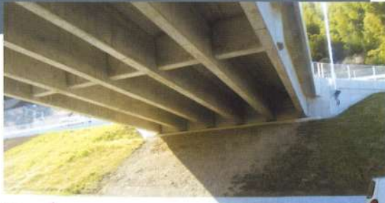
秋・三隅道路法面保護工事
