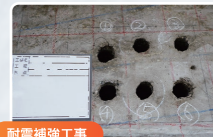
耐震補強工事
